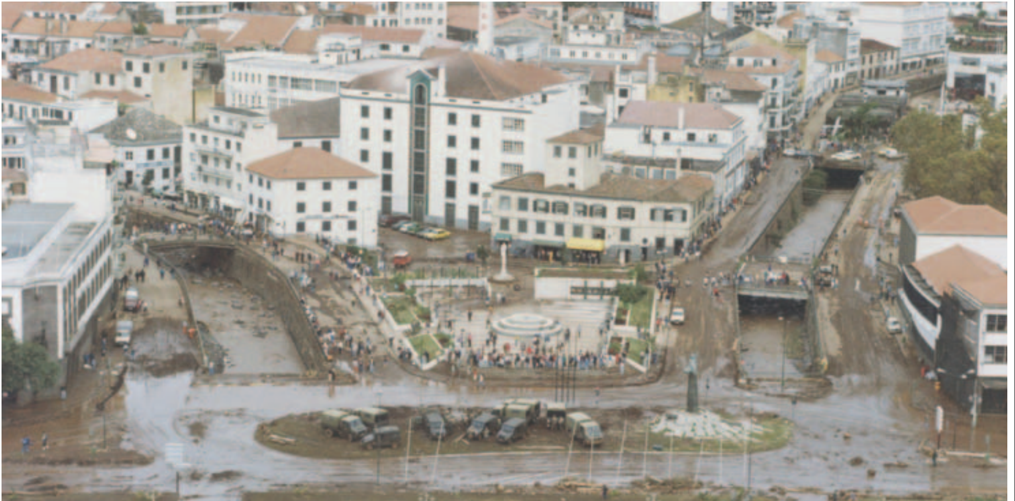
A 29 de Outubro de 1993, uma aluvião atingiu a Madeira e penalizou a cidade do Funchal em particular, causando mortos, feridos e centenas de desalojados. FOTOS ARQUIVO
