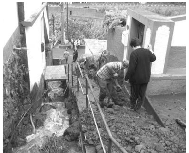
Córrego transbordou levando moradores a fugir de medo. FOTO ORLANDO DRUMOND
