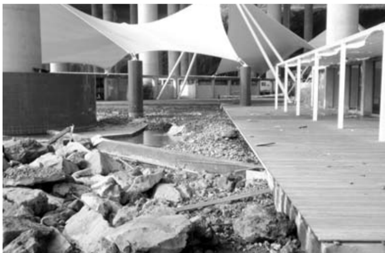
A zona do bar ficou totalmente destruída pela força do mar.
