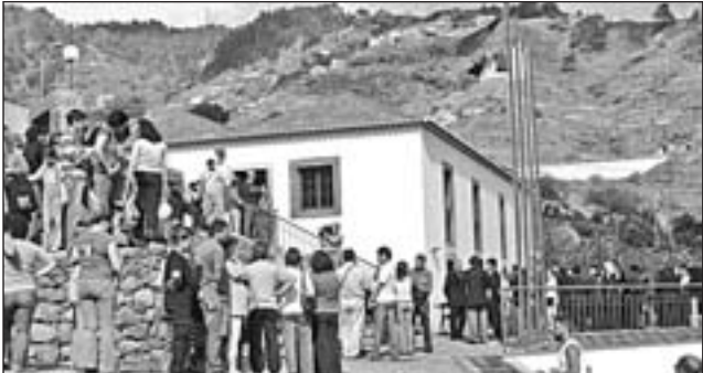
Em causa está o Solar do Massapez.
