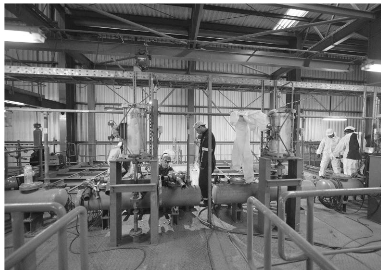
Falta de mão-de-obra especializada encarece trabalhos em curso.
