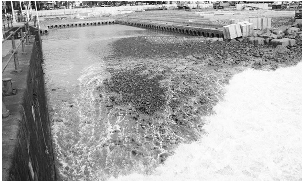
Zona junto ao cais e atrás da marina está assoreada, funcionando como uma rampa. FOTO RAIMUNDO QUINTAL
