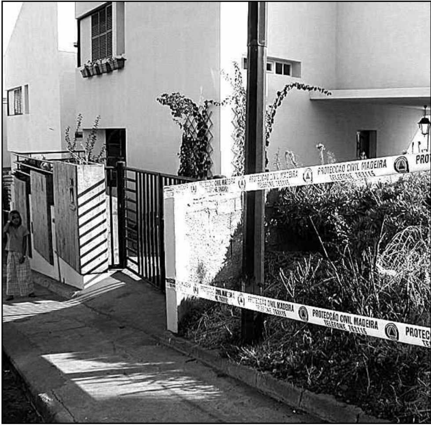
Zona de perigo vedada pela Protecção Civil.
