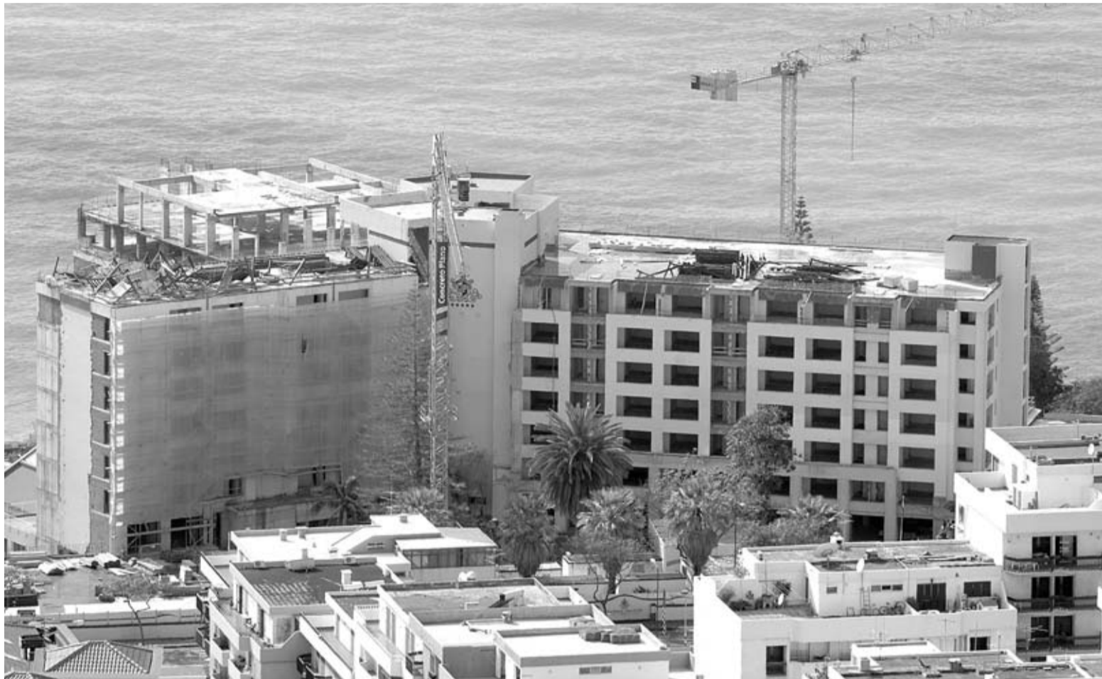
A Fibeira precisa de mais dinheiro para continuar as obras, bancos não emprestam. FOTO ARQUIVO
