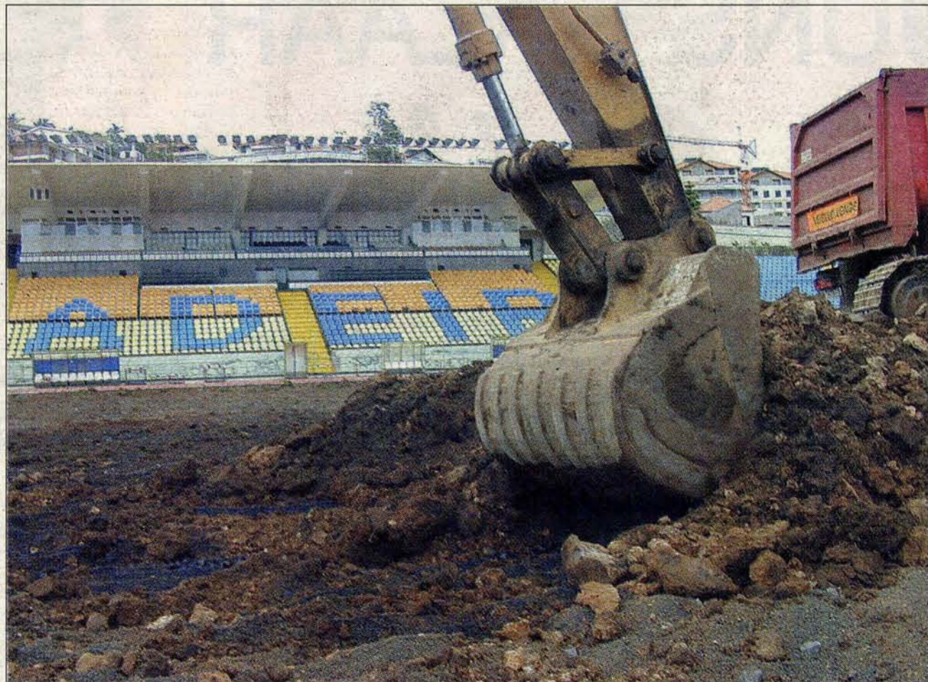
A máquina no "meio" do terreno.
