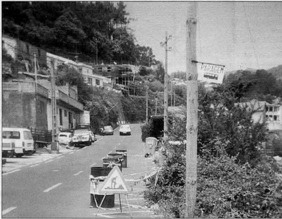
Estrada em constante perigo de sofrer nova derrocada, coloca em sobressalto família que vive abaixo da zona acidentada.
