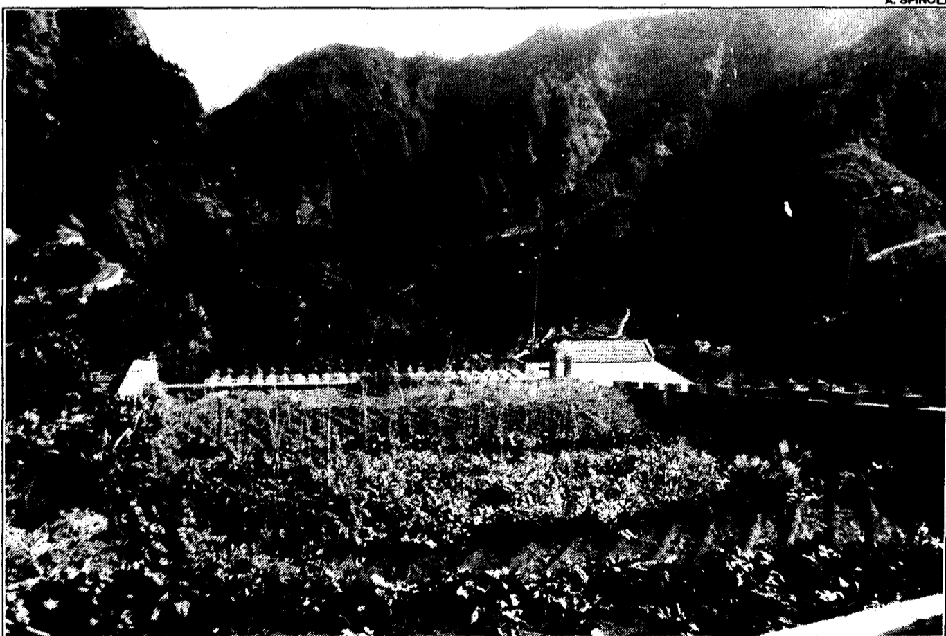
Alberto João Jardim visitou ontem o local onde irá ser construído o novo Centro de Saúde do Curral das Freiras.
