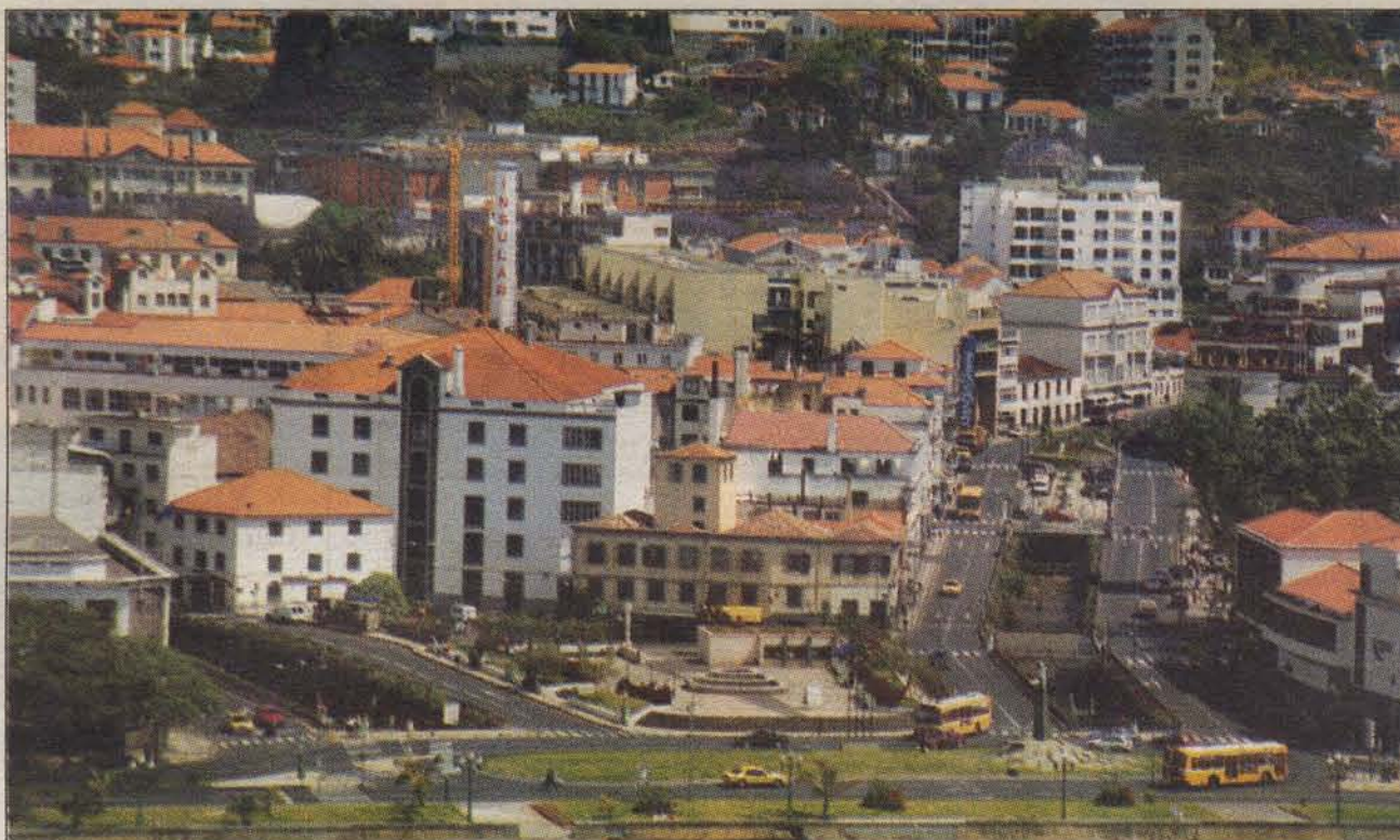
O Grupo Sá adquiriu as antigas instalações da Companhia Insular de Moinhos para construir um hotel de cidade.
