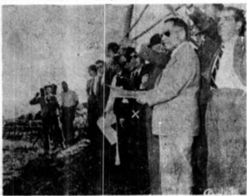
O sr. Ministro das Comunicações (X) acompanhado de diversas entidades, oficiais e técnicos, visitando em Agosto de 1960 o local onde seria construído o Aeroporto do Funchal.
