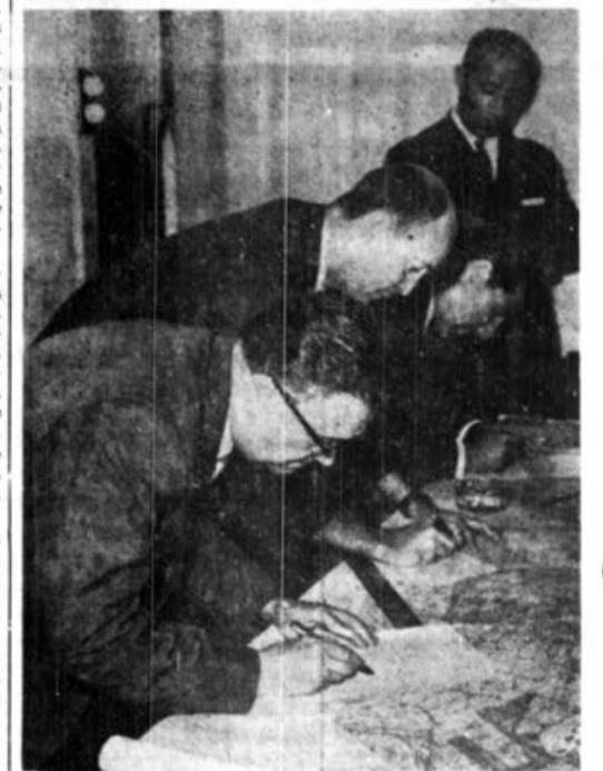
18-7-61 assinatura do auto de concessão dos trabalhos de construção do Aeroporto do Funchal à firma «Construtora do Tamaga, Lda», cujo sócio gerente se vê em primeiro plano, seguido dos Srs. Eng. Corvo Mendes e fiscal Bernardino Palmeira, da Direcção-Geral da Aeronáutica Civil. Ao fundo, vemos ainda o sr. Rui Falcão Costa, director do Aeroporto.
