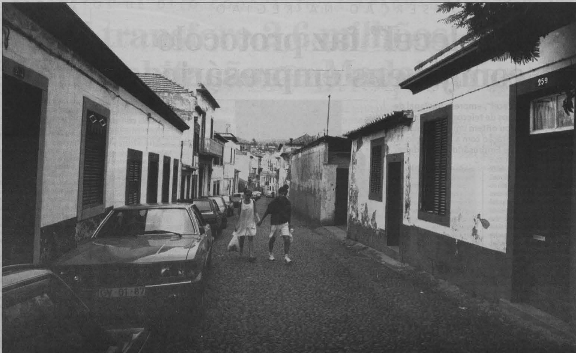
A Rua de Santa Maria vai ser toda repavimentada, embora mantendo a sua calçada original.
