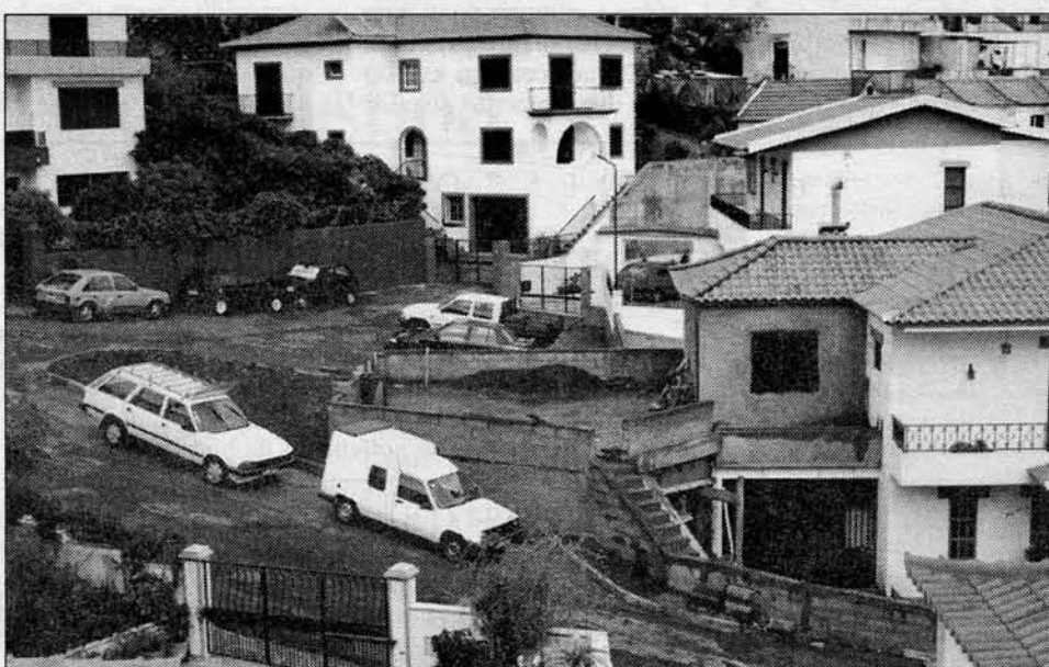
A câmara diz que as obras estão paradas devido a um embargo. Os moradores garantem que os trabalhos decorrem normalmente.
