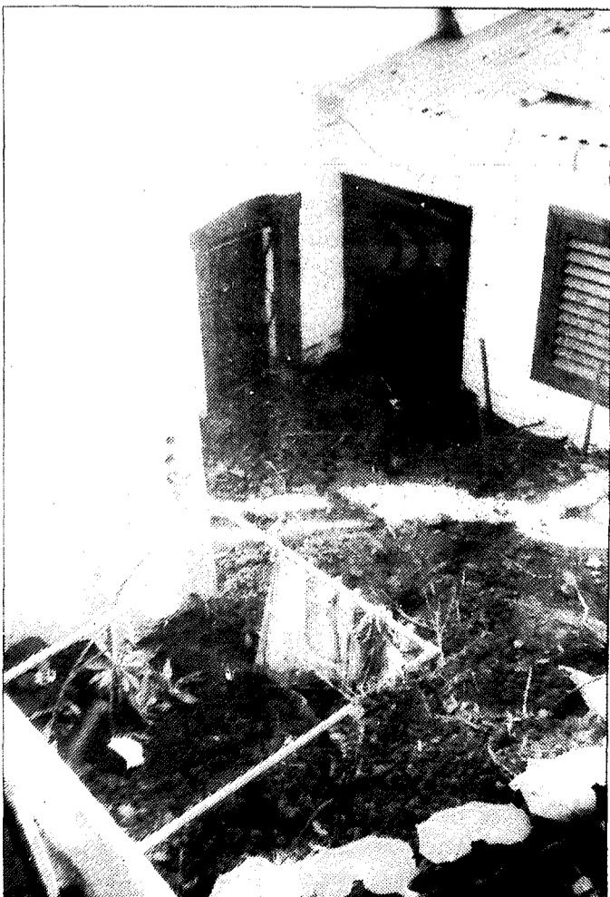
A quantidade de terra que se abateu sobre algumas das pequenas casas é bem visível...
