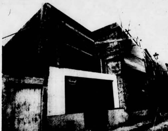
Aspecto das obras que estão a ser feitas na A. D. Machico. (Foto M. Nicolau)
