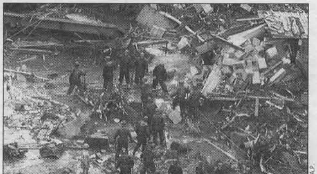
A destruição é bem evidente.
