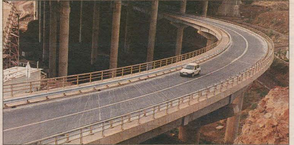
Viaduto de acesso ao aeroporto e a Água de Pena já está aberto ao trânsito
