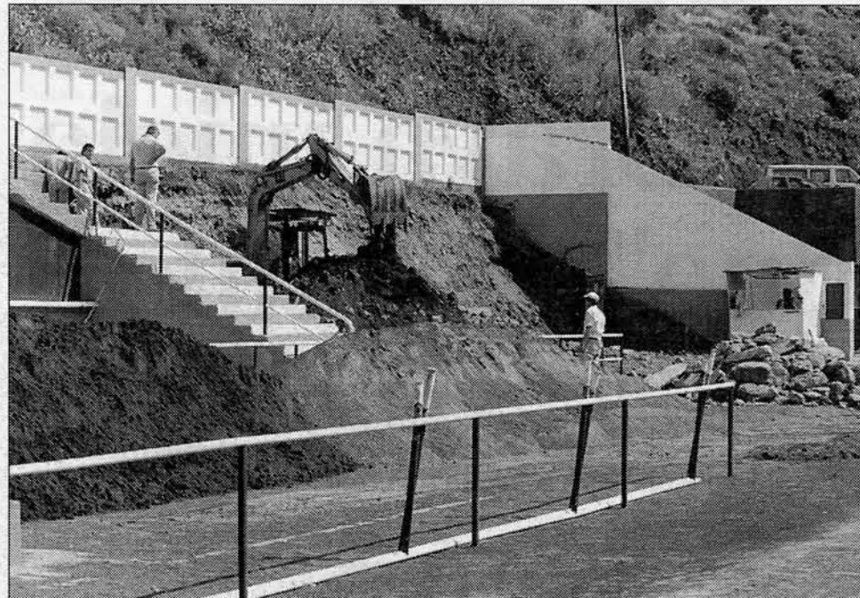
O campo de futebol da Ribeira Brava já está em obras.
