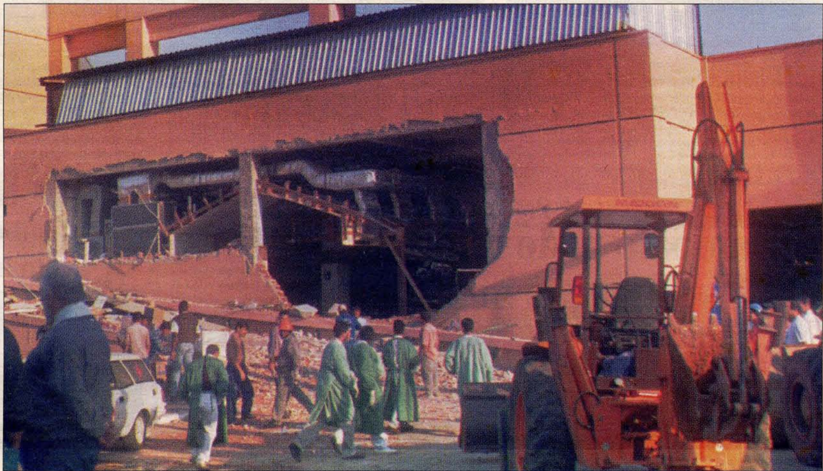
Uma fuga de gás pode ser a causa da tragédia que provocou o pânico na cidade.
