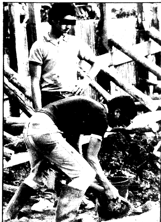
Abandonaram a escola para ganhar uns trocos, «fazendo massa» e pondo «bloco por cima de bloco».
