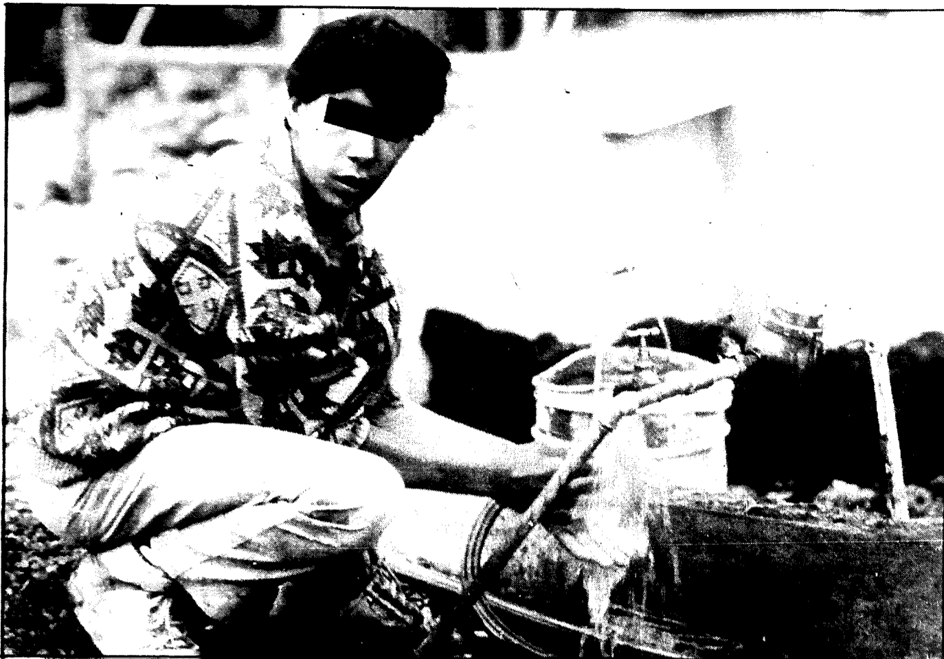
O momento mais desejado: a lavagem rápida do cimento do corpo, porque já soaram as 18 horas e o dia já está ganho.
