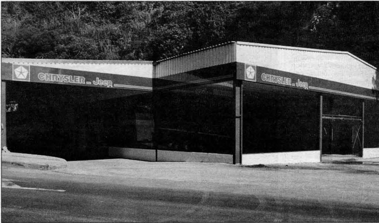
É este o stand que foi alvo da notificação da edilidade funchalense. Em causa estão as obras de ampliação.
