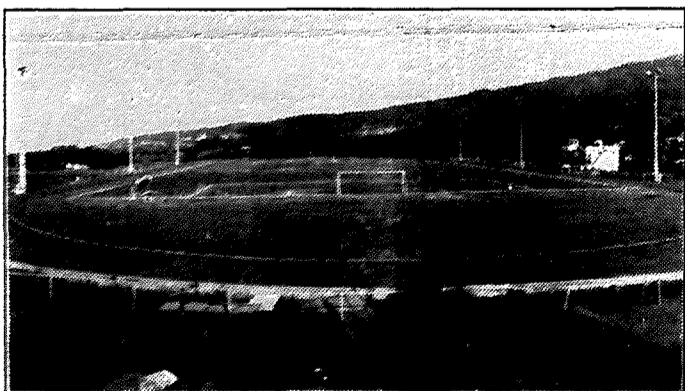
MUNICIPAL DOS PRAZERES — CALHETA c/ iluminação
