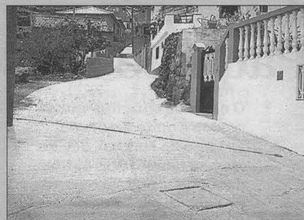
Um dos caminhos recentemente alargados.
