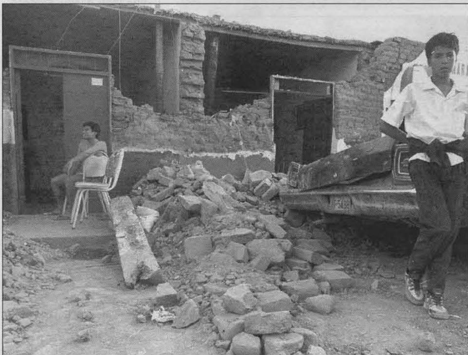
Muitas casas ficaram completamente destruídas.
