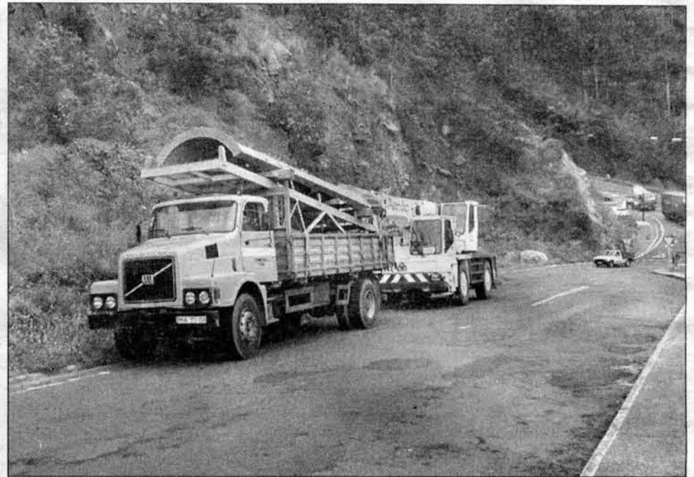
Os camiões com as estruturas metálicas e a grua que iria dar apoio na sua montagem não chegaram a passar da Rua de Santa Luzia.
