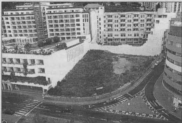
A Estrada Monumental é uma das artérias em pior estado da cidade do Funchal. Este ano arrancam as obras.
