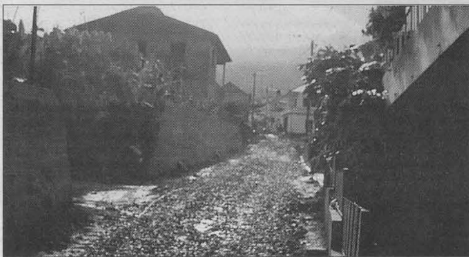
A nova estrada em construção.
