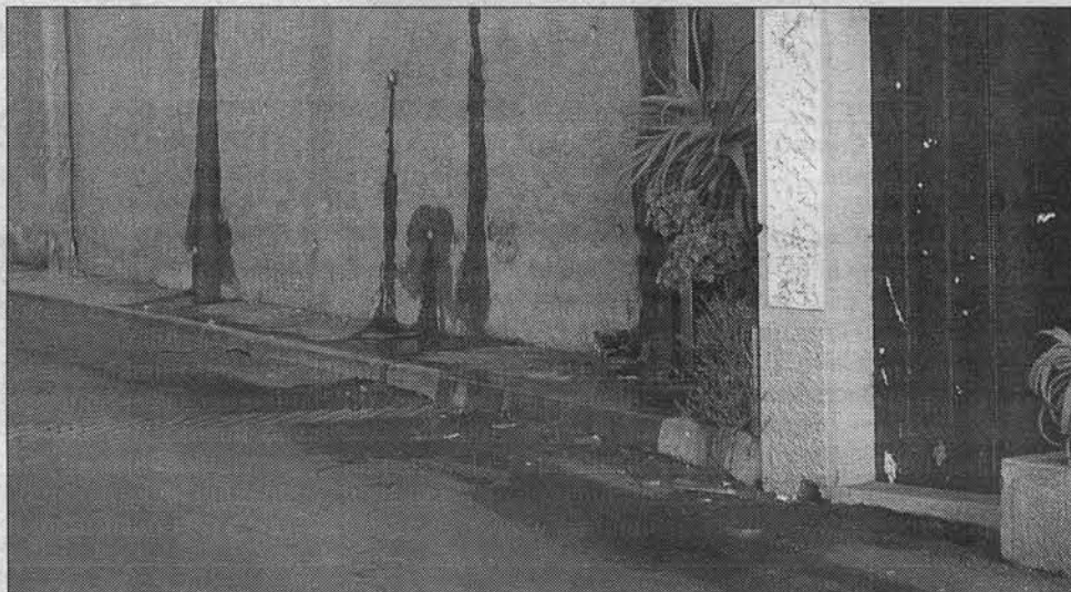
A foto mostra bem a sujeira que escorre sobre o asfalto.
