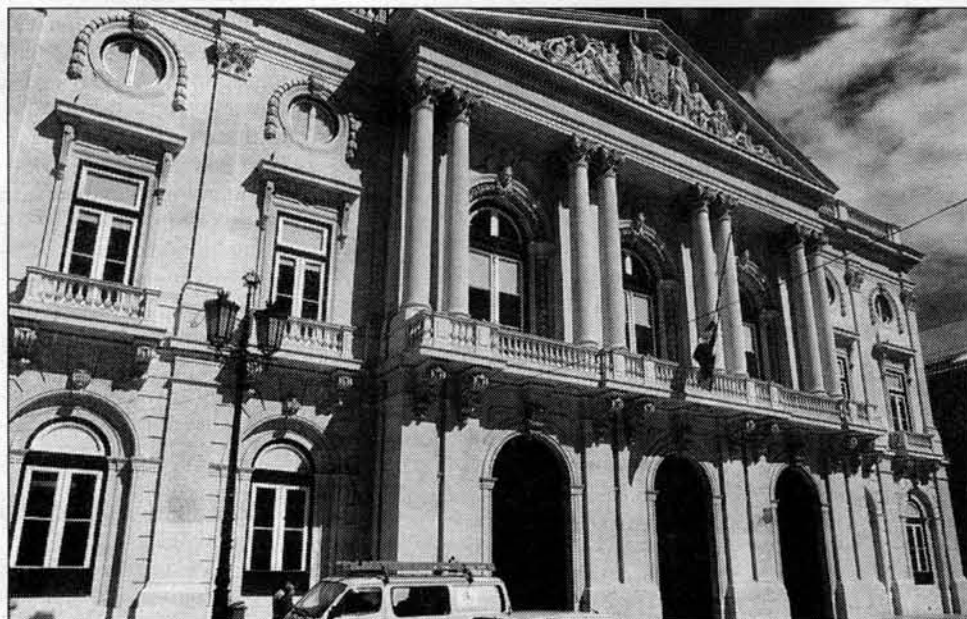
O incêndio destruiu grande parte do edifício da Câmara Municipal de Lisboa.
