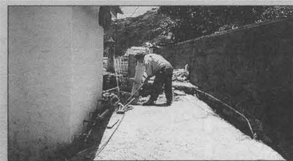
Obras de pavimentação de uma vereda.
