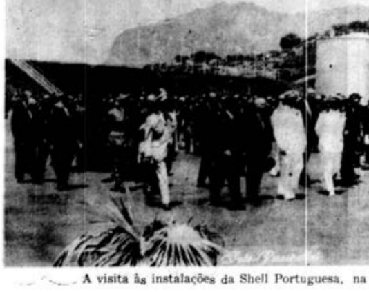
A visita às instalações da Shell Portuguesa, na Praia Formosa
