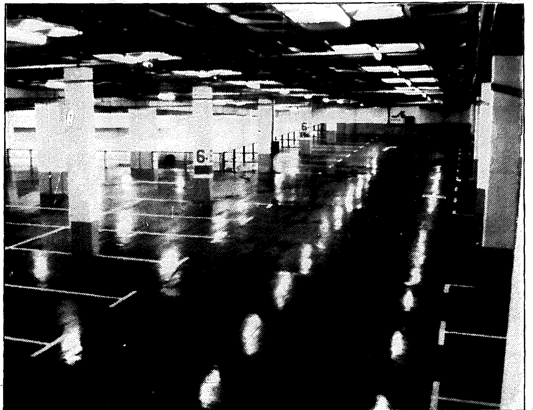
O auto-silo de S. João tem capacidade para 600 viaturas.
