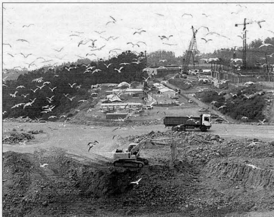
Enquanto o muro de suporte do aterro não fica concluído, o lixo é depositado em bolsas sanitárias improvisadas (buracos escavados na encosta).
