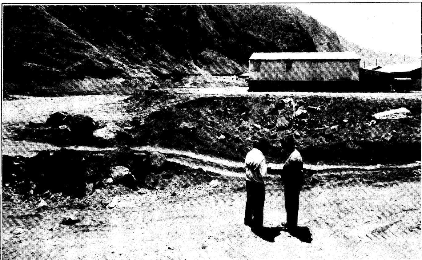
Alberto João Jardim irá visitar o campo relvado de São Vicente, ainda em fase de construção. Uma infra-estrutura desportiva que deverá estar concluída, conforme disse ao «DN» Gabriel Esmeraldo, até 1993.
