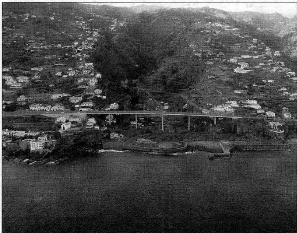
O espaço a recuperar situa-se na foz da Ribeira da Boaventura e encontrava-se abandonado há cerca de 17 anos.
