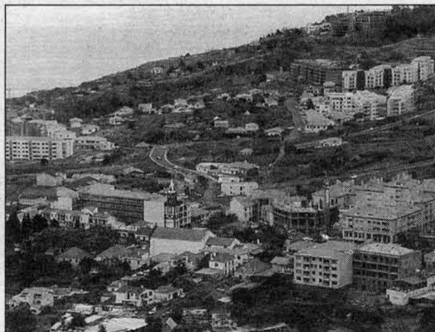
No Canico, a construção já não se cinge ao centro. Há prédios por todo o lado.
