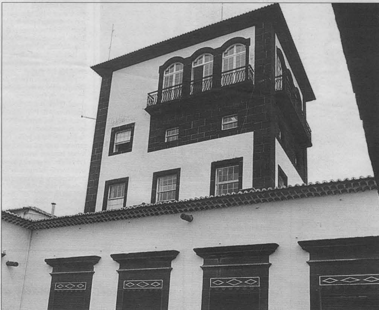
O Serviço Municipal de Protecção Civil está a ser instalado na torre do edifício da câmara.
