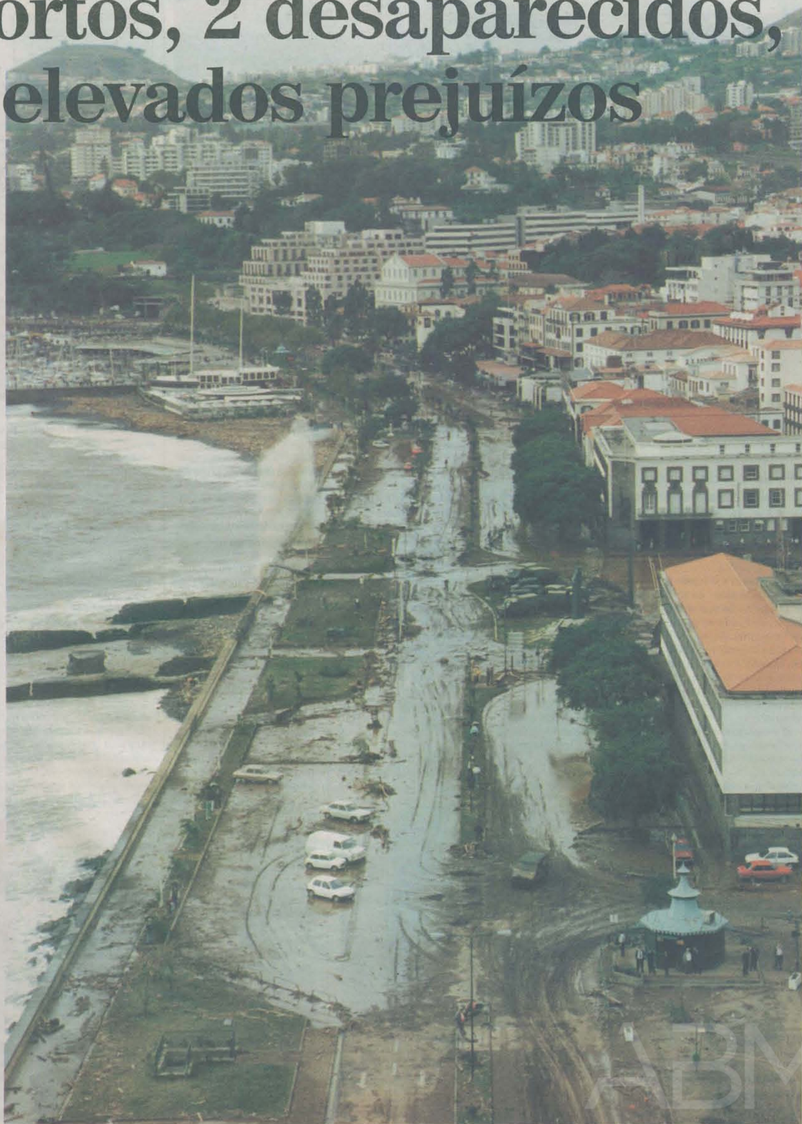
Vista aérea do estado em que se encontrava a Avenida do Mar, ontem a meio do dia.
