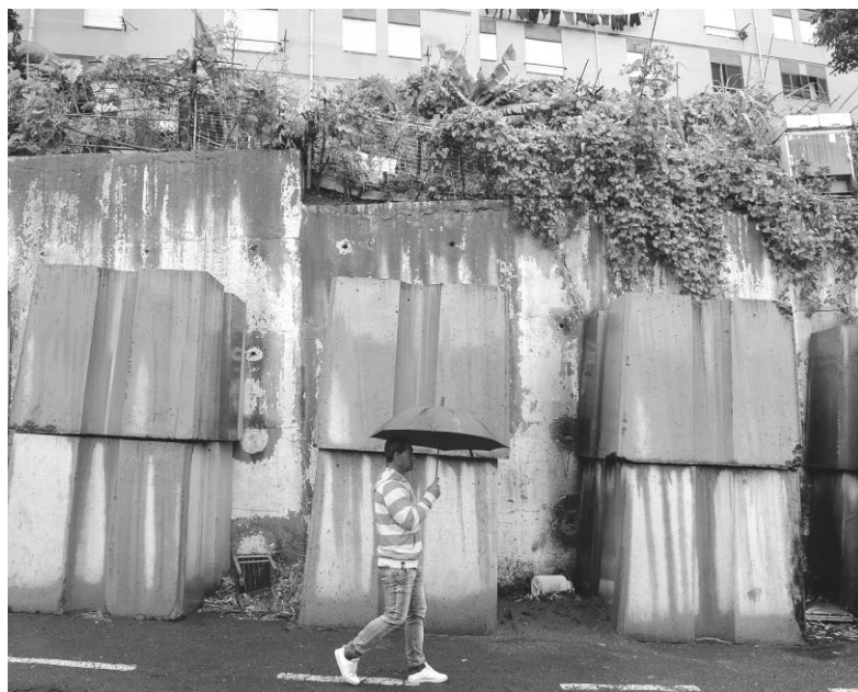
Blocos de betão usados para proteger o litoral da erosão seguram as muralhas "evitando que caíam aos bocados".
