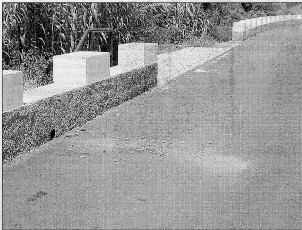
A terra no asfalto esconde as marcas deixadas pela violência do sinistro.
