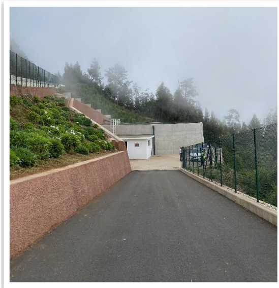
Figura 2 - Reservatório e respetiva câmara de manobras.
